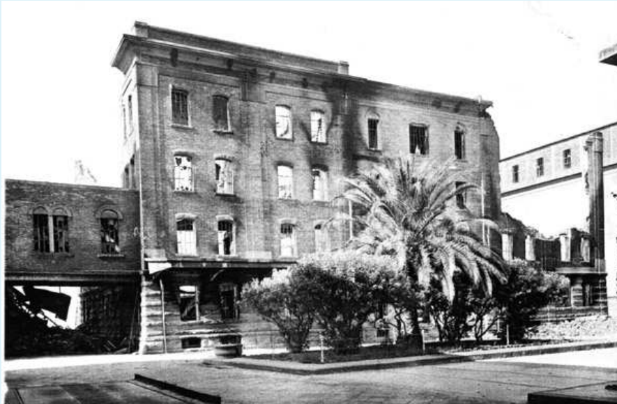
1.10 - Il deposito delle farine minato dalle truppe tedesche nel 1943
