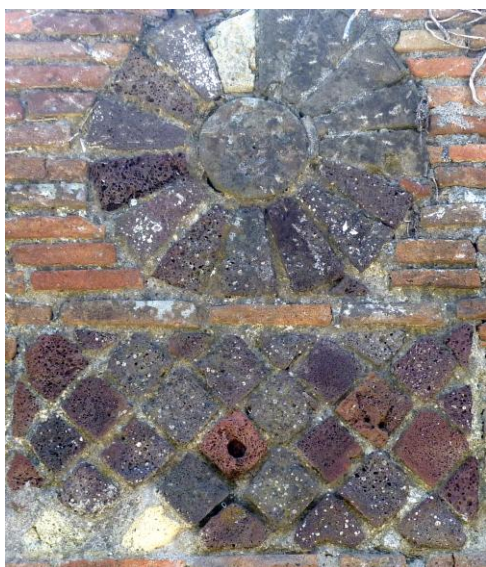
Figura 1. Un esempio di utilizzo della ottavianite spugnosa come materiale da costruzione: muratura in opus reticulatum dell'edificio VI, 12, 6.
