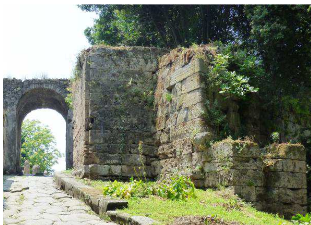
Figura 69. Pompei, Porta di Nola: terza fase delle mura con paramento a blocchi squadrati di travertino.
