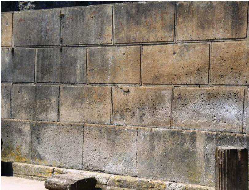
Figura 72. Facciata in opera isodoma di tufo della casa della Fontana Grande a Pompei. Su un filare inferiore di ortostati lisci, le assise correnti sono perfettamente ritmate da cesellature d'inquadrimento che sottolineano i giunti.
