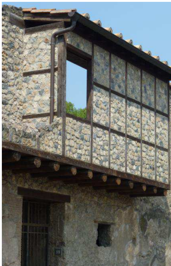
Figura 76. Tramezzi in opera a graticcio con riempimento in opus incertum di un piano superiore (Pompei, I, 10, 18).
