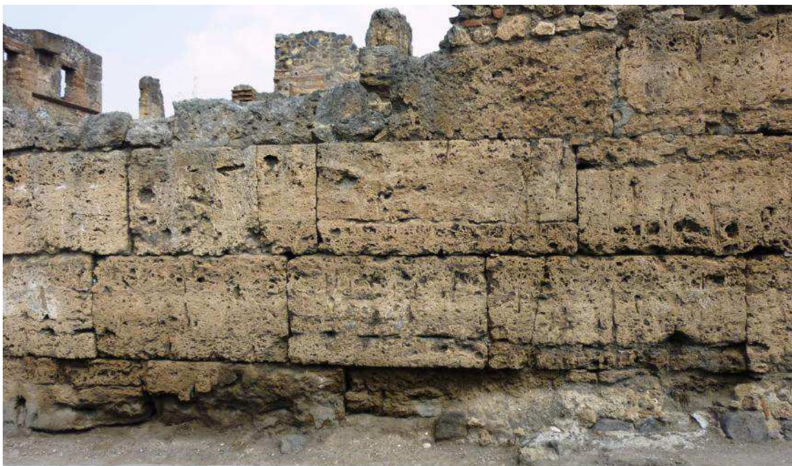
Figura 71. Paramento murario a ortostati e diatoni di travertino (Pompei: I, 6, 1).
