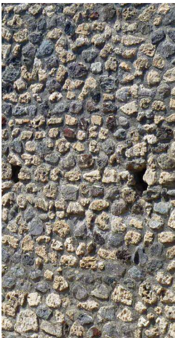
Figura 78. La varietà delle pietre utilizzate nell'opera incerta, ben si adatta all'incastro di materiali di natura diversa, come le malte, gli stucchi o altro (Pompei, VI, 7, 22).
