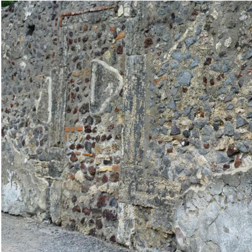
Figura 75. Muro in opus africanum a catene verticali di blocchi di travertino e riempimento in pietre laviche (Pompei, I, 12, 1).
