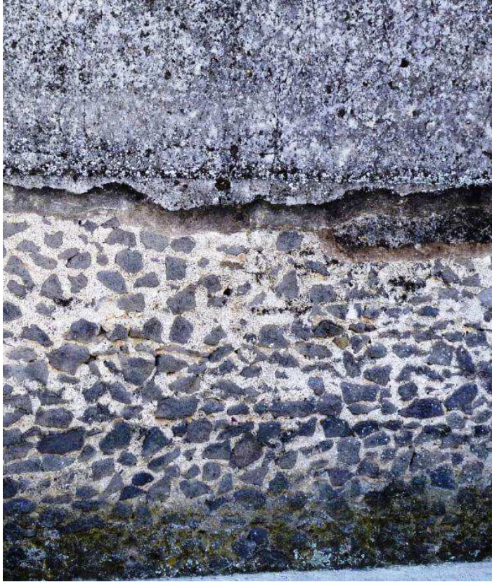
Figura 79. Muro perimetrale della Basilica: opus incertum con impiego di blocchetti di tufo grigio assemblati con malta di ottima qualità ricoperti di stucco.
