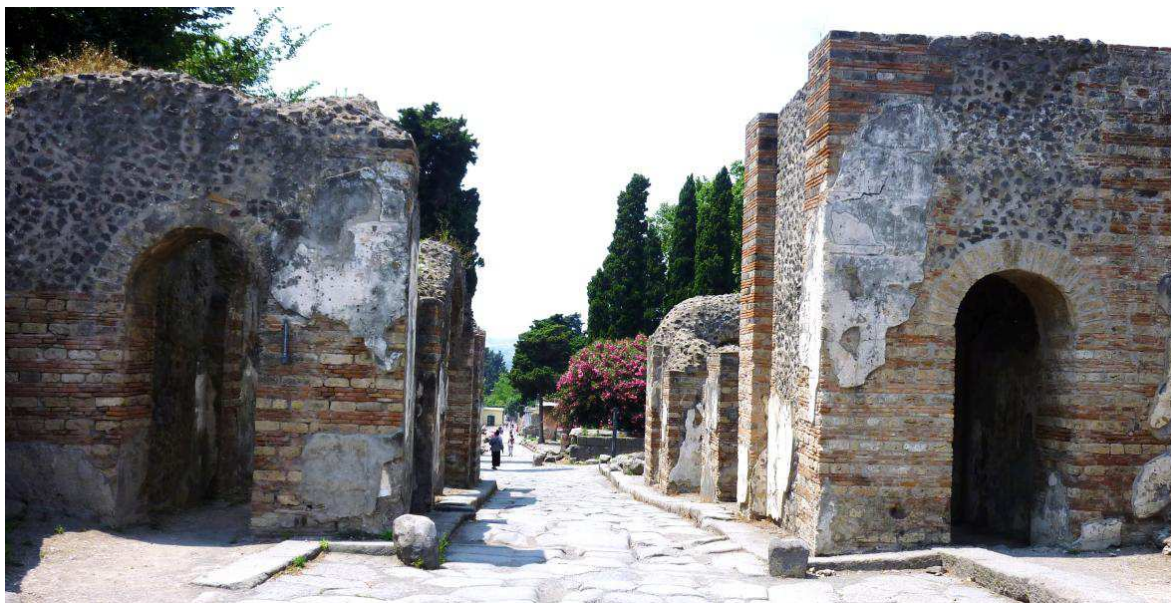
Figura 86. La Porta Ercolano a Pompei, costruita tra l'80 a.C. e l'età augustea. La muratura presenta un paramento in opera incerta di pietre laviche, con ampie catene angolari in opera mista di tufo e mattoni, probabilmente l'esempio più antico conosciuto a Pompei. L'arco centrale e la sua volta, crollati a causa degli eventi sismici, non furono mai ricostruiti. Le pareti erano rivestite di stucco imitante l'opera quadrata.
