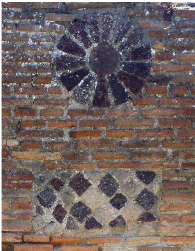
Figura 85. Pompei (VII, 3, 8): paramento in opus testaceum con inserti policromi anche in opera reticolata e evidenti tracce di intonaco.
