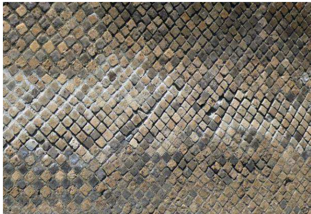
Figura 84. Opera reticolata da Pompei (VI, 3, 25) in cui risultano evidenti certe esitazioni nel raccordare due lotti di lavoro. Le dimensioni delle pietre oscillano tra cm 7x7 e cm 8x8.
