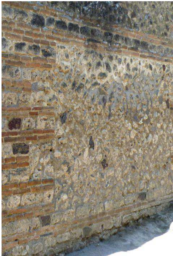
Figura 80. Esempio di muratura composita dell'ultima fase pompeiana, che sfugge ad una precisa tipologia, poiché vi troviamo l'opera incerta con ricorsi in opera mista e catene angolari alternativamente di mattoni e in opera mista (VII, 12, 16).
