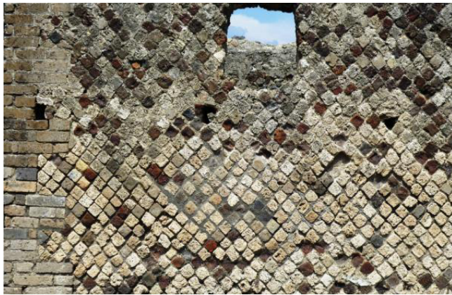
Figura 83. Facciata in opera reticolata con giochi cromatici ottenuti grazie all'impiego di diverse pietre locali. Le catene angolari sono in blocchetti di tufo (VI, 6, 18).
