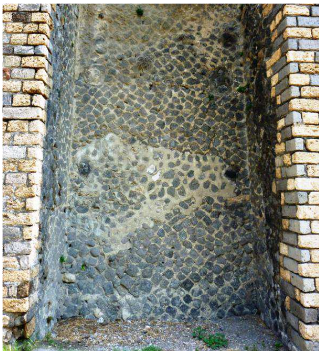
Figura 81. L'anfiteatro di Pompei, come l'Odeon e le terme del Foro, appartiene a quegli edifici costruiti dopo la deduzione della colonia sillana nell'80 a.C.; in esso si ritrova una relativa unità costruttiva sotto forma di paramento in opera quasi reticolata che mette bene in evidenza il vantaggio cronologico della Campania su Roma, e al tempo stesso le incertezze che ancora contraddistinguono questa tecnica di nuova importazione.
