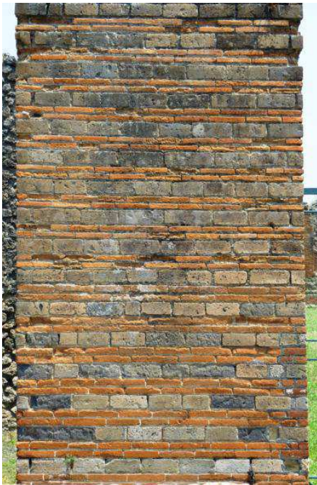
Figura 88. Tipo di opera mista in uso a Pompei nel corso dell'ultima fase edilizia, visibile in una bottega delle terme centrali (IX, 4, 4). La regolare alternanza di un filare di blocchetti e due di mattoni non può costituire un indizio cronologico, poiché si ritrova ugualmente nel Circo di Massenzio.
