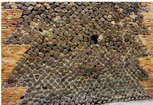
Figura 82. Opera quasi reticolata nell'Odeon di Pompei (circa 80 a.C.); sono state utilizzate pietre laviche con catene angolari realizzate con mattoni a dente di sega. Questa originale disposizione, che conta numerosi esempi a Pompei, si ritrova nel teatro di Cassino di età augustea.
