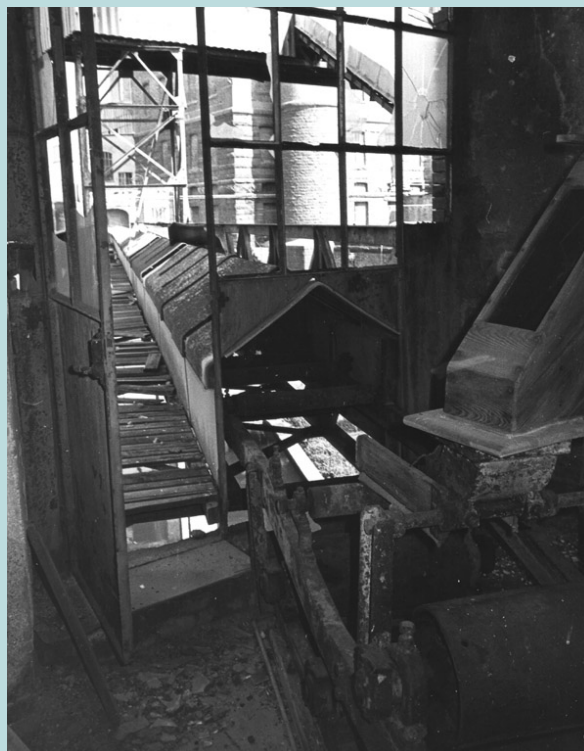
3.4 - Particolare terminale nastro torre-silos.
