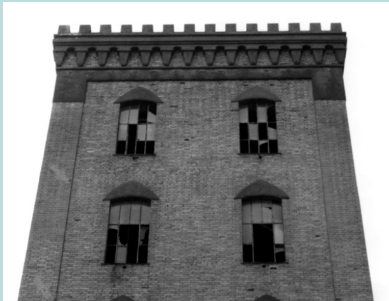
3.3 - Particolare della facciata Nord.
