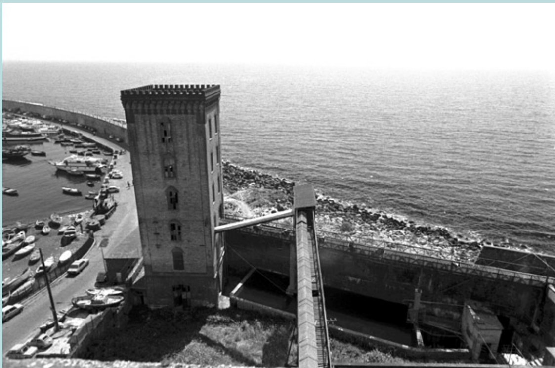
3.1 - Vista dall'alto della torre.
