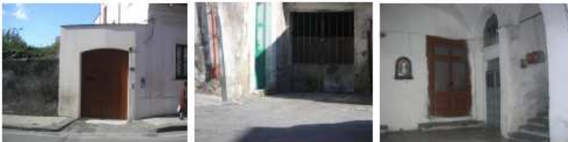
Figura 14. Alcuni degli ingressi, ormai ostruiti, alle tufare. Da sinistra: oratorio S. Domenico Savio (Piedimonte); ingresso di Pietraccetta, usato come deposito di carni macellate; ingresso in ferro di Via Ricco, all'interno le scale sono state murate.
