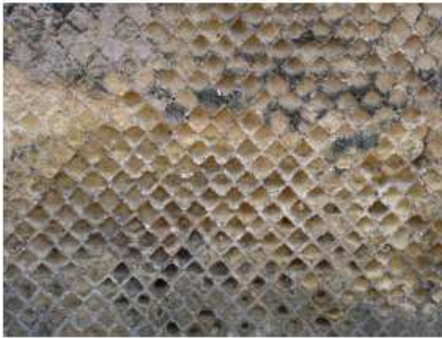
Figura 20. Muro perimetrale del Tempio di Venere in opus reticulatum .
