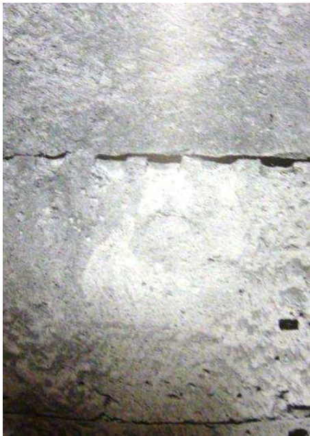
Figura 41. Blocco di tufo recante ancora gli alloggiamenti per i cunei utilizzati per scalzarlo (Pompei, VIII, 5, 30).
