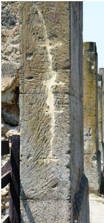
Figura 50. Tracce di un'ascia-martello su un paramento di marmo. Sulle rocce dure l'arnese attacca la superficie in modo pressoché ortogonale, lasciando solchi poco profondi (Pompei, cantiere del tempio di Venere).
