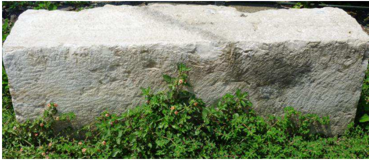
Figura 50. Tracce di un'ascia-martello su un paramento di marmo. Sulle rocce dure l'arnese attacca la superficie in modo pressoché ortogonale, lasciando solchi poco profondi (Pompei, cantiere del tempio di Venere).
