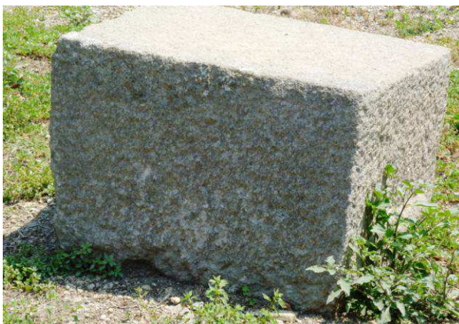
Figura 47. Taglio gradinato di un blocco nel cantiere del tempio di Venere a Pompei.
