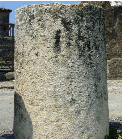
Figura 54. Blocco di calcare bianco sgrossato destinato al nuovo colonnato del Foro di Pompei, portato dalla cava con i paramenti già gradinati.
