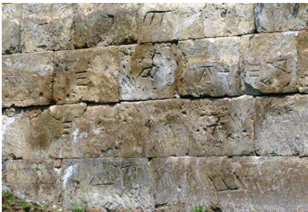
Figura 60. Segni apposti dai cavapietre per indicare la destinazione dei blocchi (Pompei, cinta muraria di Porta Nocera).
