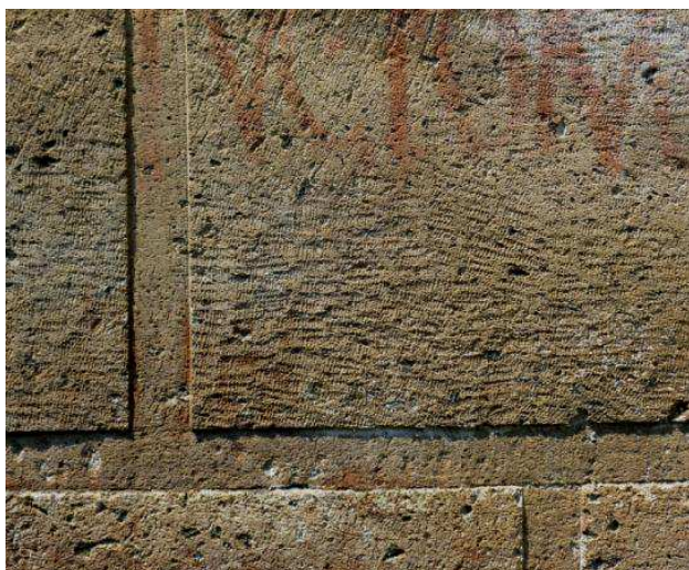
Figura 56. Sbozzo effettuato in parte con il maglietto e in parte con la gradina; giunti levigati (molati). Pompei, tomba 14, Porta di Nocera.
