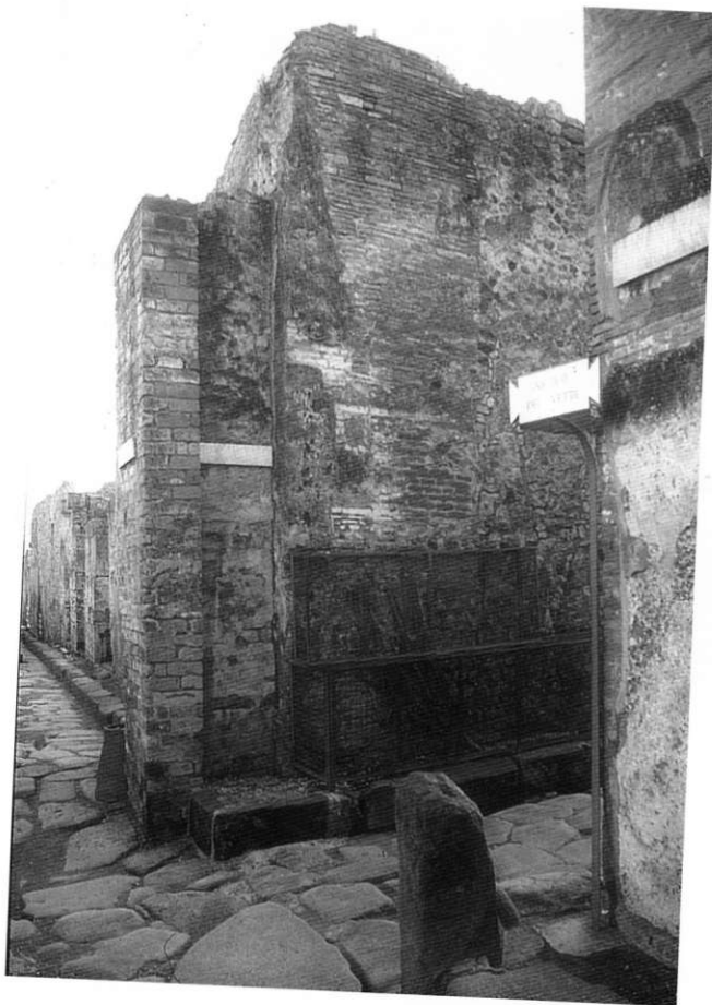
Fig. 2 - Castellum plumbeum nell'angolo Nord-orientale dell'Insula IV-13
