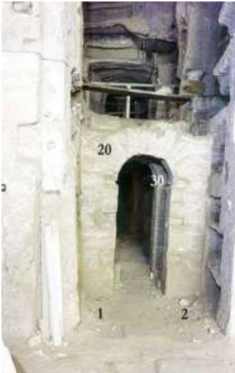
15a. Gli archi in muratura 20 e 30 all'imbocco della galleria B8 (AICC, foto 1365, modificata).
