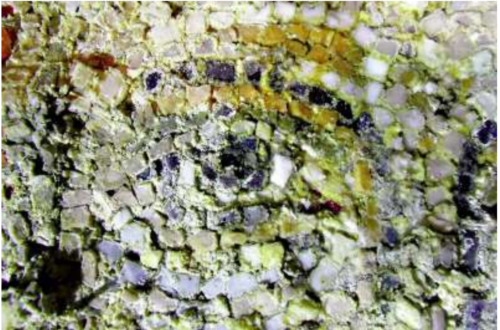
12. Napoli, Catacombe di San Gennaro, cripta dei vescovi: particolare durante l'intervento di restauro del 2015 (foto PCAS).
