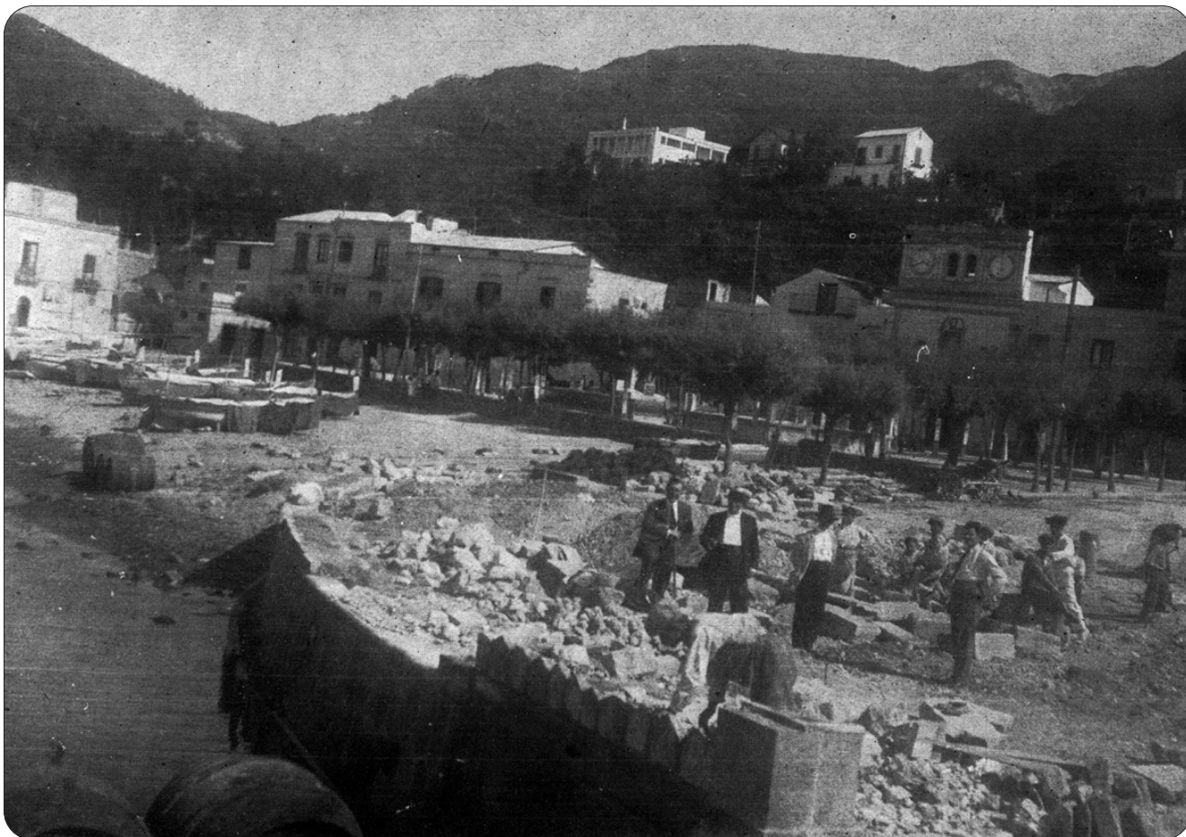
Allargamento della Piazza (lavori in corso)
