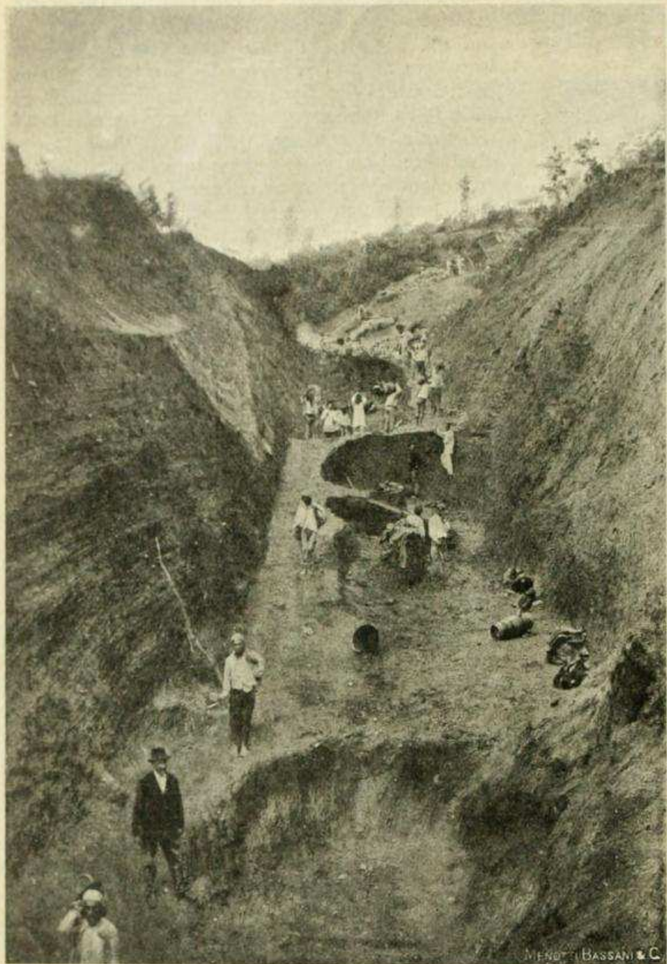
SCAVI PER LA NUOVA FERROVIA ELETTRICA.
