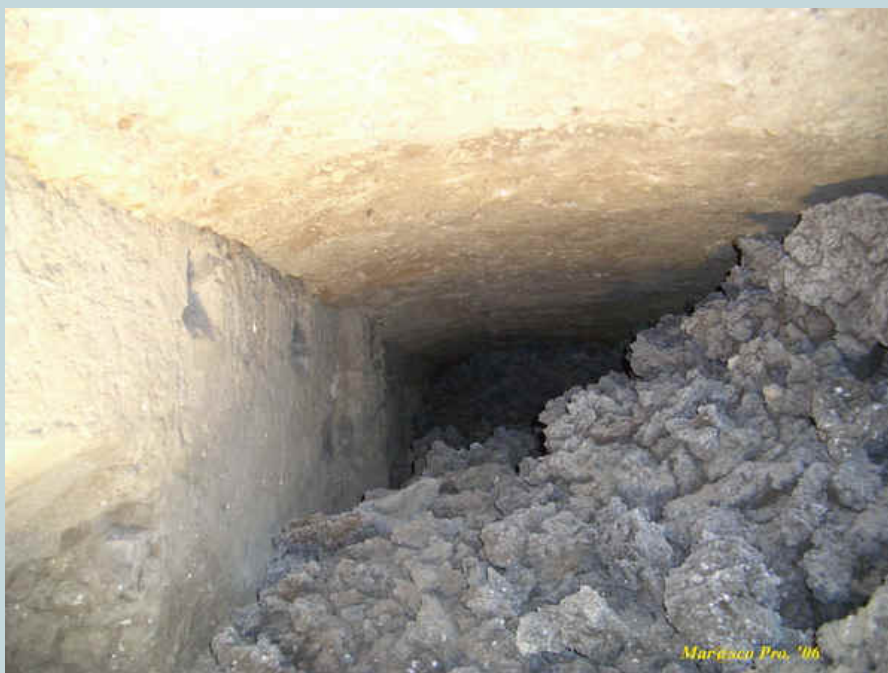
Foto 4 - Locale di accesso
