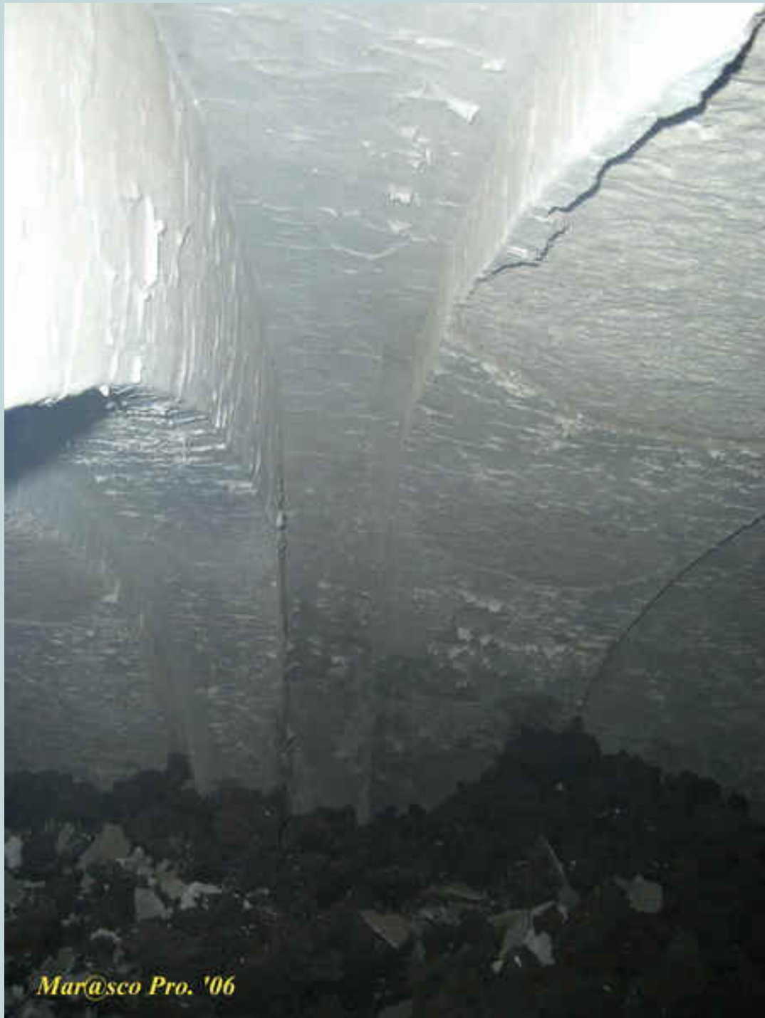
Foto 21 - Particolare delle volte della zona Sud.
