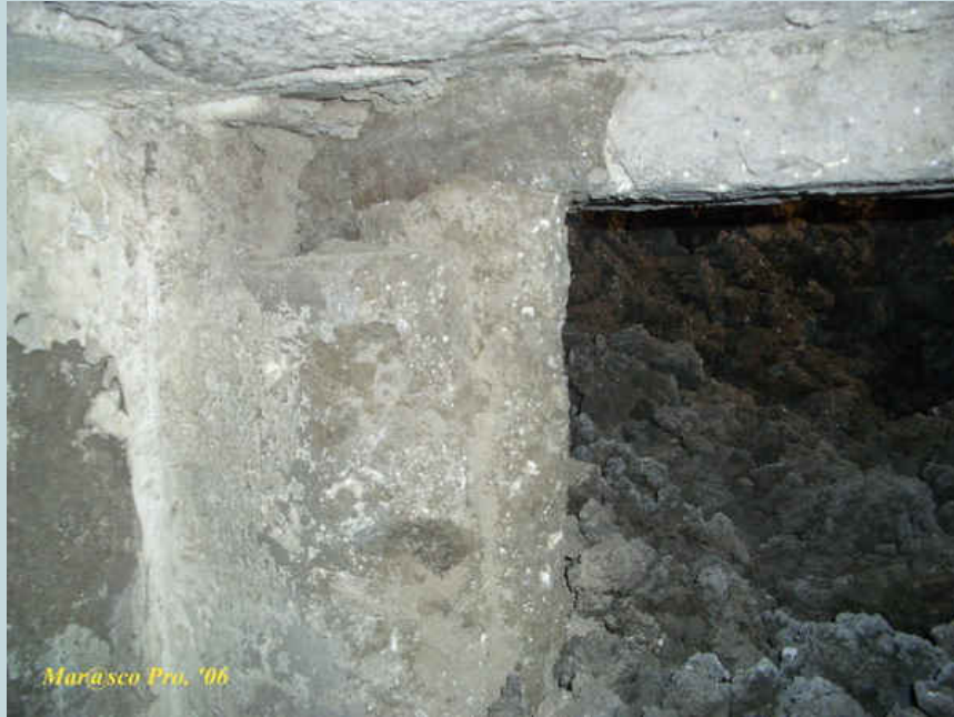
Foto 7 e 8 - Particolari interni dell'ingresso.
