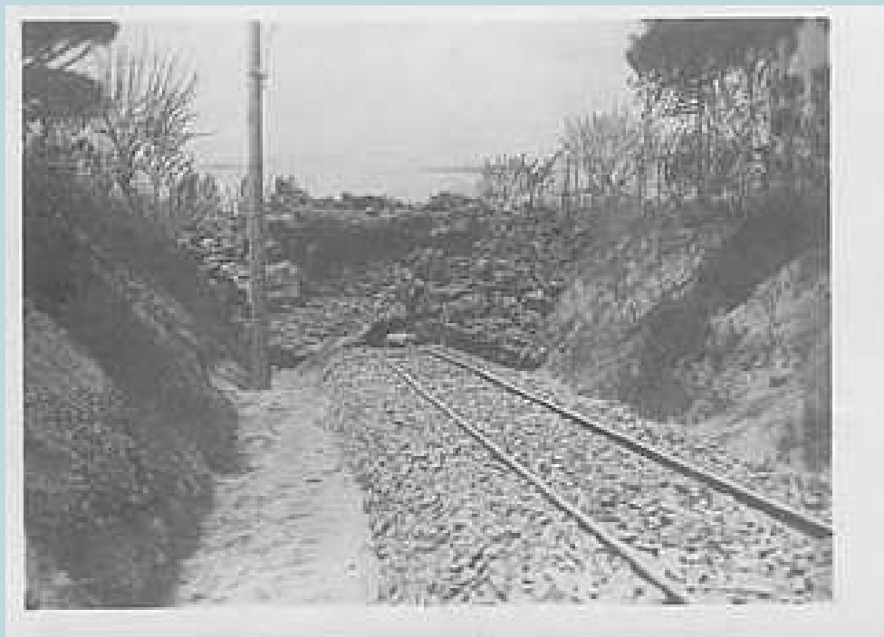
Foto 82 - La ferrovia Circumvesuviana interrotta dalle lave.
