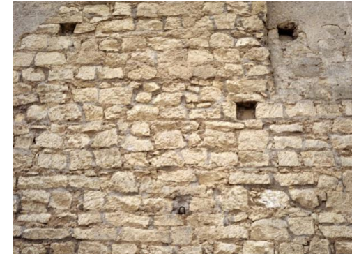
Castel Sant'Elmo (Napoli). Particolari degli apparecchi murari «a cantieri»
