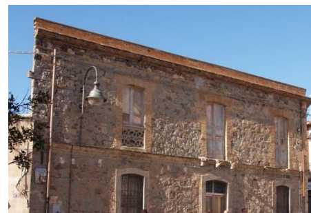
Fig. 14 Casa realizzata con trachite di Serrenti (Sud Sardegna)
