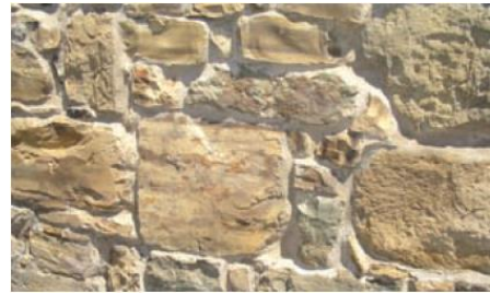
Fig. 16 Conci di marna calcarea in opera a Villanovaforru (Sud Sardegna)
