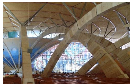
Fig. 8 Particolare degli archi della Chiesa di San Pio realizzati in "Bronzetto"
