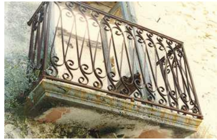
Fig. 6 Tavolone di balcone realizzato con lastra monolitica di calcare (Senerchia)
