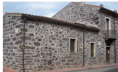
Fig. 15 Apparecchiatura muraria ad elementi di basalto in una tipica abitazione locale (Ghilarza, Oristano)
