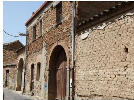
Fig. 18 Abitazione realizzata in Lådiri (varietà di Adobe)
