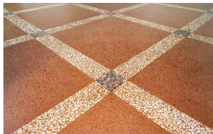
Fig. 7 Pavimento in battuto di Cocciopesto con inserti lapidei
